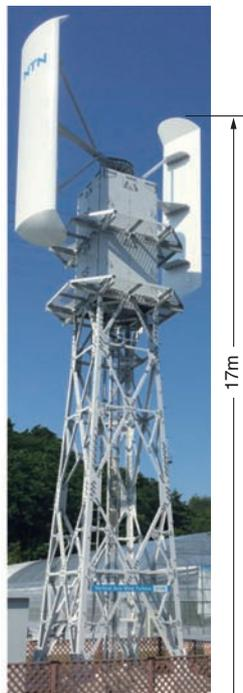
Fig. 11 10kW Wind Turbine
