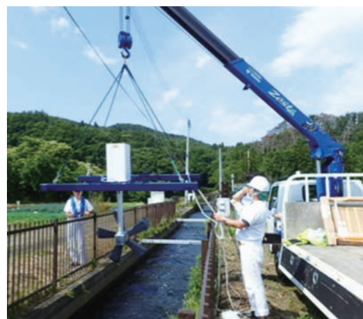
図10 マイクロ水車の設置作業 Installation operation
