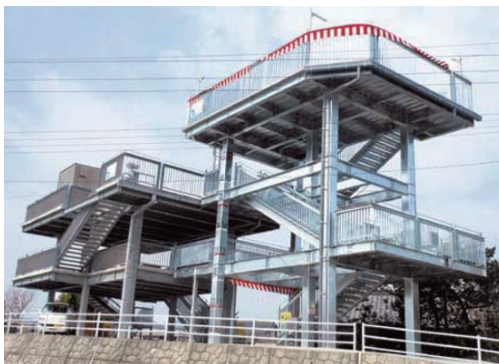
高知県四万十市 下田水戸津波避難タワー 5)
