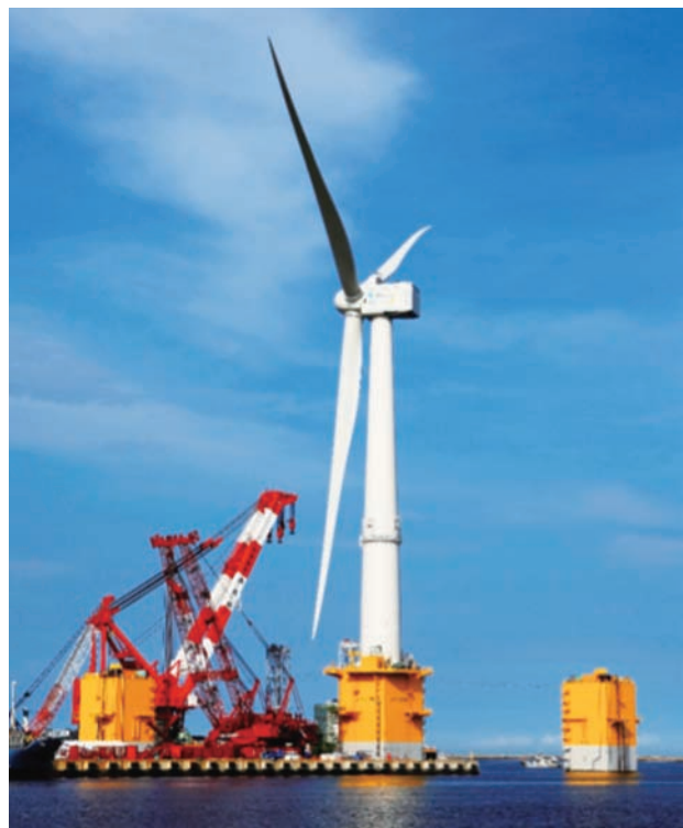
図14 世界最大のロータ直径の風車 (直径167m、定格7MW、風車ブレード上端高さ189m 提供：Toru Nagao) Largest-diameter wind turbine in world (diameter: 167 m, rated power: 7 MW, height of blade top: 189 m Courtesy : Toru Nagao)
