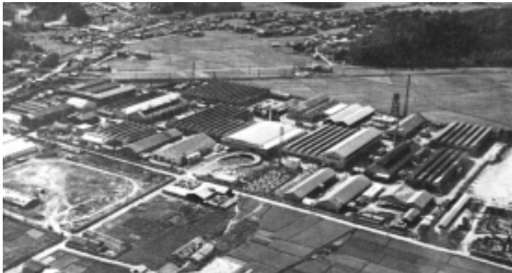
写真1 1960年頃の桑名製作所 KUWANA PLANT in 1960
