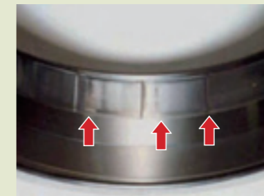
段付摩耗発生
