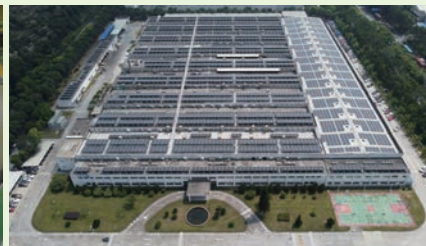
太陽光パネルによる電力供給 (中国：廣州NTN)
