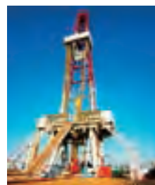
石油・ガス関連プラント 設備補修
