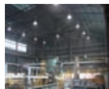
水銀灯からメタルハライドランプに取り替えた当社桑名製作所熱処理工場
