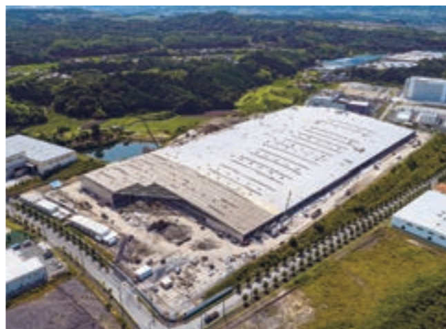
建設中の和歌山製作所(2019年7月末撮影)
