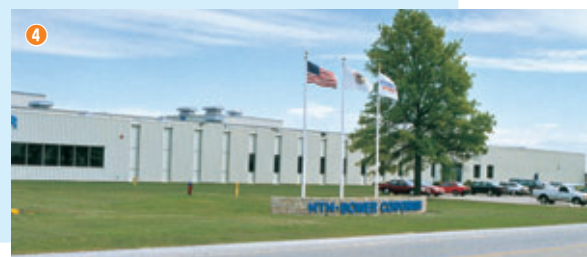
第2工場が2013年5月に竣工予定の NTN-Bower マコム工場
