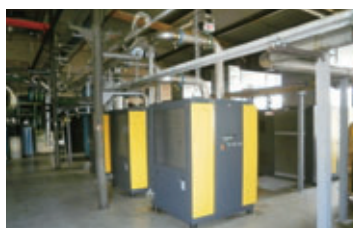
NTN-SNRの新冷媒空調設備
