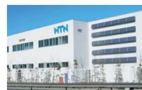
(株)NTN 三重製作所の太陽光パネル
